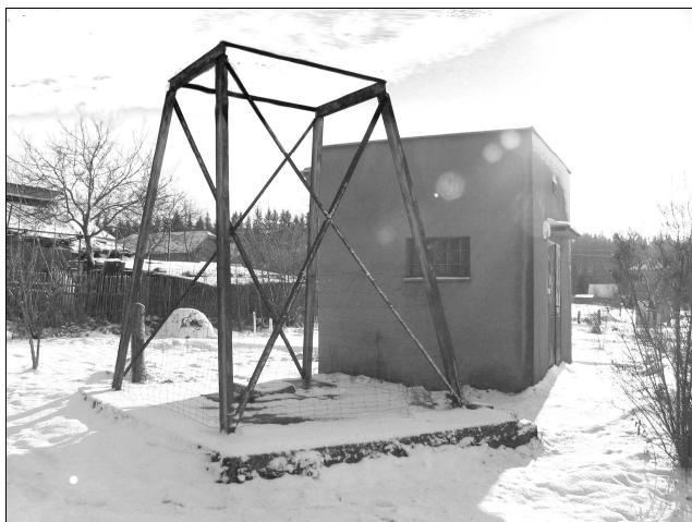
Celkový pohled na vodárnu
