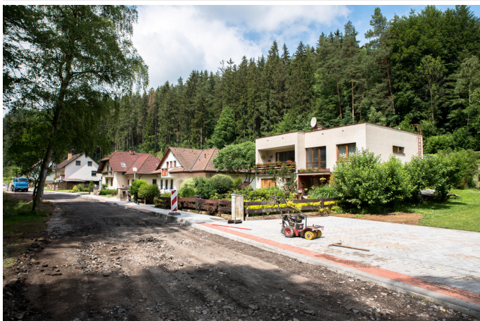
Chodník ke koupališti a stav komunikace před pokládkou asfaltu
