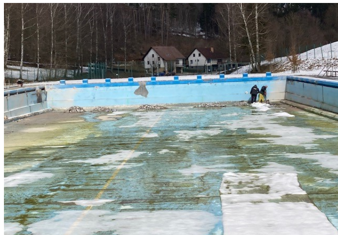
Pokračují práce na rekonstrukci bazénu na koupališti
