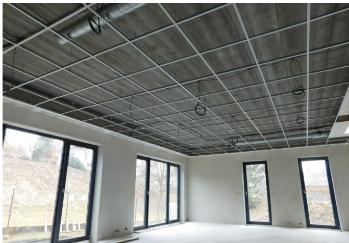
Probíhající rekonstrukce Mateřské školy
