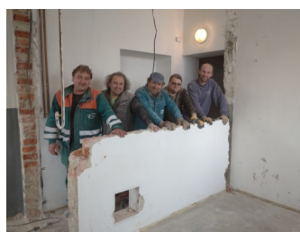
Rekonstrukce šaten v hasičské zbrojnici
