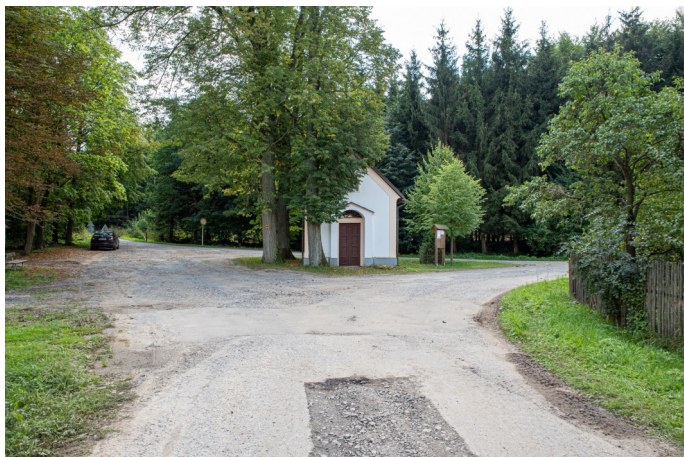
Stav před rekonstrukcí
