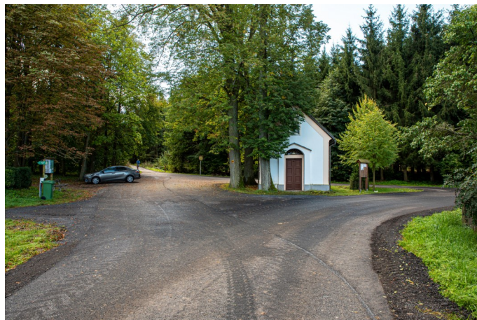
Stav po rekonstrukci
