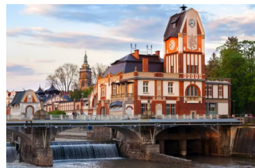
Secesní budovy Labské vodní elektrárny jsou technickou památkou
